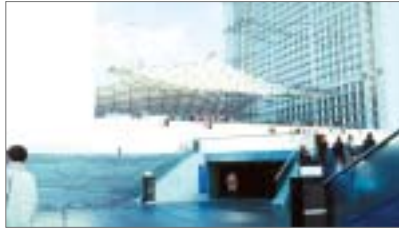
Peter Rice, Paris'te Le Grand' Arche binası giriş saçağı. Asma germe sistemle 'bulut'.
